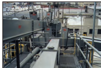
Aerodeslizadores distribuyendo a varios silos, utilizando la combinación de cajas de volteo y compuertas deslizantes verticales.
