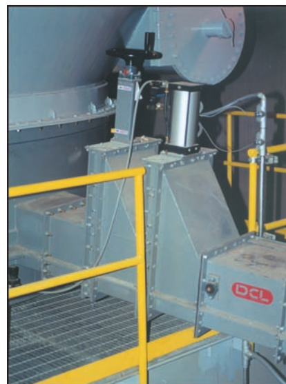
Válvula vertical manual y válvula deslizante neumática.
