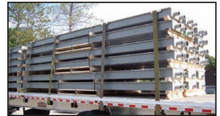
Canales de ventilación para la instalación en el piso de la bóveda.
