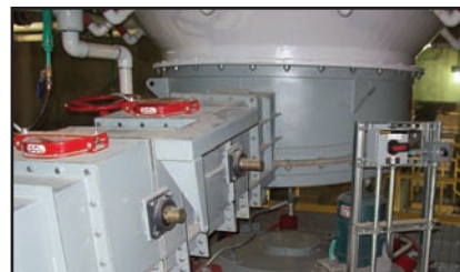
Fondo aireado, con descarga lateral y válvulas de control de flujo.
